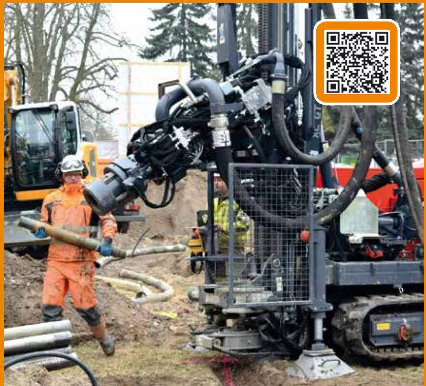
Beim Bau der ›Schwanen Villa‹ wird auf Erdwärme gesetzt. Ende März erfolgten die Bohrungen und das Einbringen der Erdwärmesonden in 100 Meter Tiefe.
