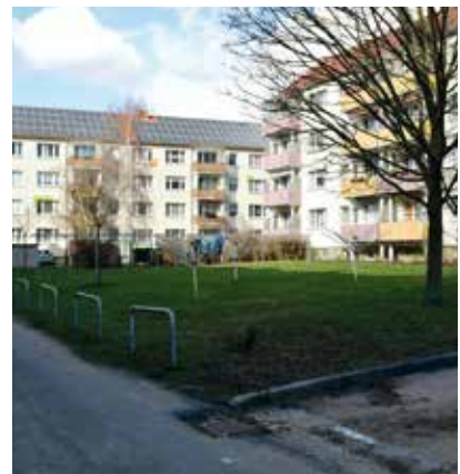
Auf dem Hof der Steinstraße 37 bis 47 sind etwa 12 Stellflächen geplant. Zudem wird der desolater Gehweg saniert. Der Baubeginn ist für den Mai vorgesehen.
