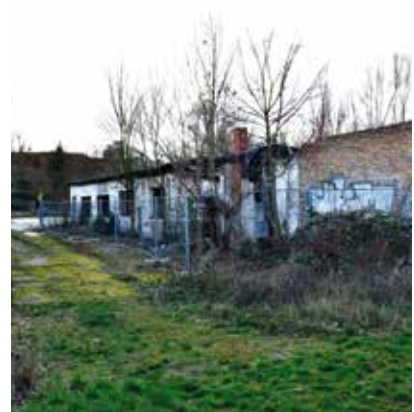
Die Baracke hinter dem »Kietz Karree« ist bald Geschichte. Der Abriss wird noch in der ersten Jahreshälfte erfolgen.
