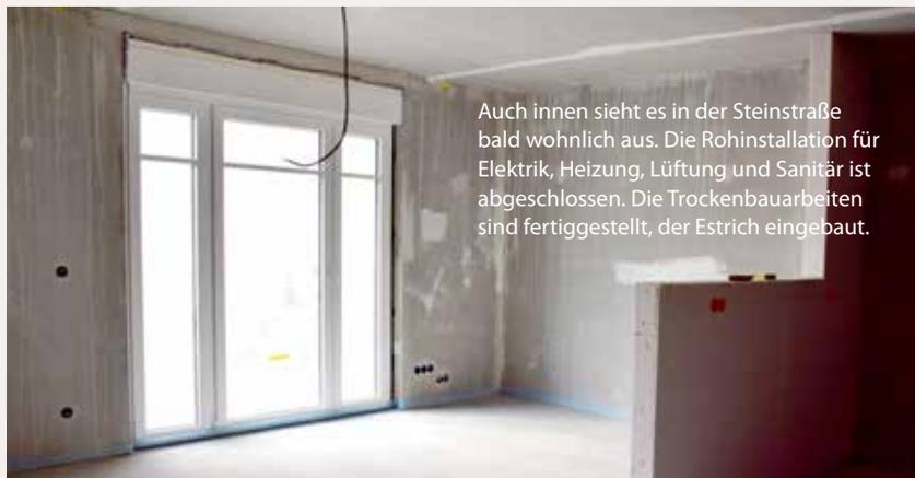
Auch innen sieht es in der Steinstraße bald wohnlich aus. Die Rohinstallation für Elektrik, Heizung, Lüftung und Sanitär ist abgeschlossen. Die Trockenbauarbeiten sind fertiggestellt, der Estrich eingebaut.
