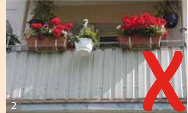
**1 Richtig:** Der Blumenkasten ist von allen Seiten gesichert und kann nicht aus der Halterung rutschen. | **2 Falsch:** Die Blumenkästen könnten bei starkem Wind links und rechts aus der Halterung rutschen. Die Blumenampel könnte so wie angebracht bei der nächsten Böe hinabstürzen und im schlimmsten Fall eine andere Bewohnerin oder einen anderen Bewohner des Hauses treffen.
